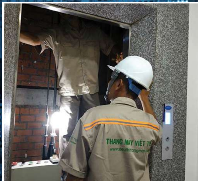
Thi công, vận hành tại công trình
